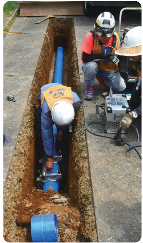
ポリエチレン製の耐震給水管同士の接合作業＝7月2日、E駐車場
